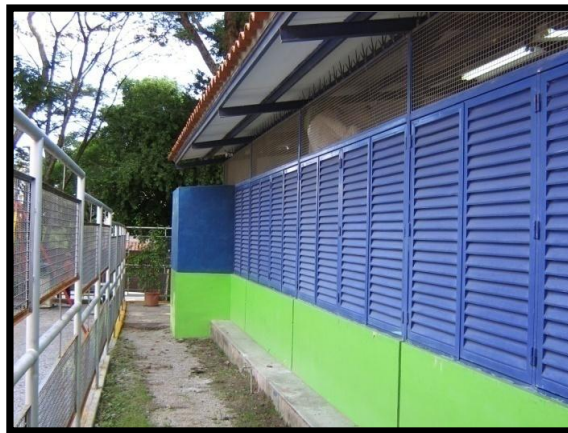
Figura 4.13.15 Edificación 1. Fachada posterior
