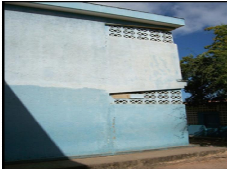
Figura 4.6.5.- Fachada Este y Oeste
