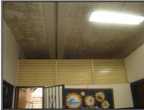
Anexo 4.15.7.- Ventana Interna, planta baja, edificio A.
