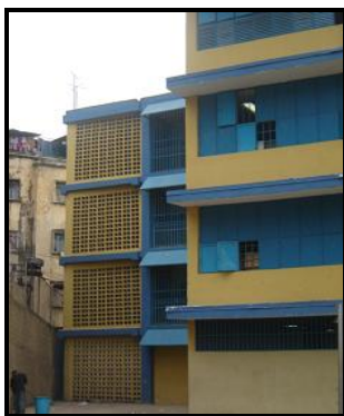
Figura 4.10.13.- A la izquierda se observa uno de los módulos independientes de la escalera, a la derecha se observa el otro; ambos con paredes de ventilación. También se observan las estructuras anexas en la imagen derecha. E. B. N. Elías Rodríguez.
