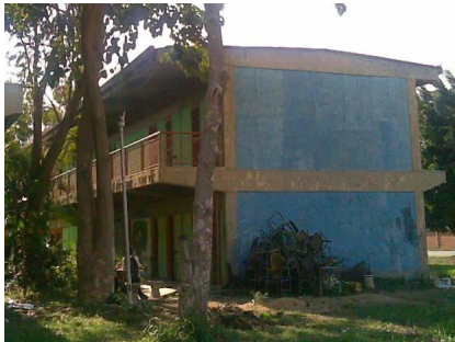
Anexo 4.16.21.- Fachada este del Módulo 4.
