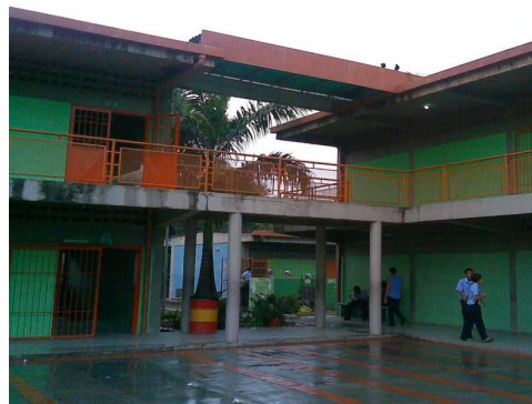
Anexo 4.16.11.- Pasillo que comunica el Módulo 2 con el Módulo 1.
