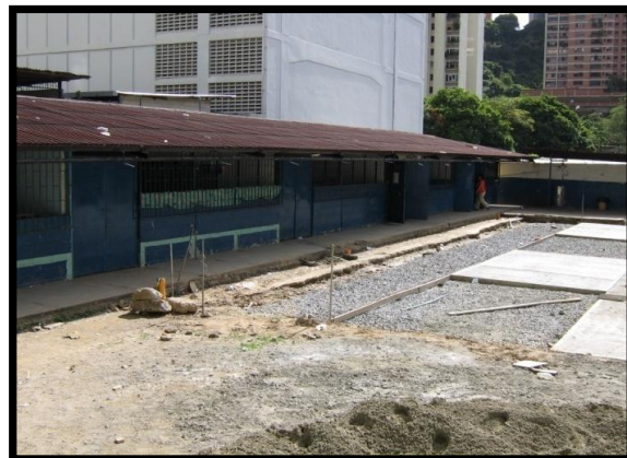
Figura 4.13.6 Edificación 2. Tipo R-4, cubierta láminas metálicas corrugadas
