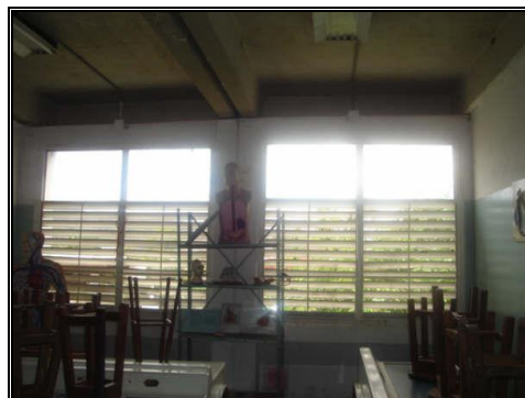
Anexo 4.15.36.- Laboratorio, tercer piso, edificio A.
