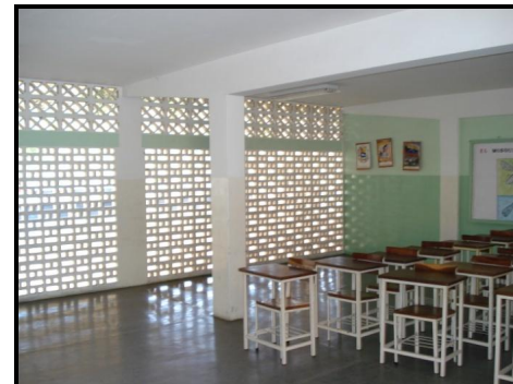
Figura 4.6.13.- Salones de clases sin la presencia de bancos de concreto
