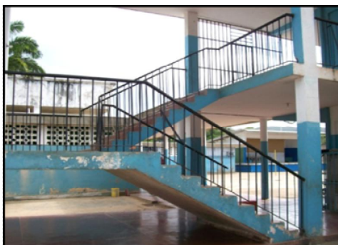
Figura 4.6.18.- Modulo de Escaleras
