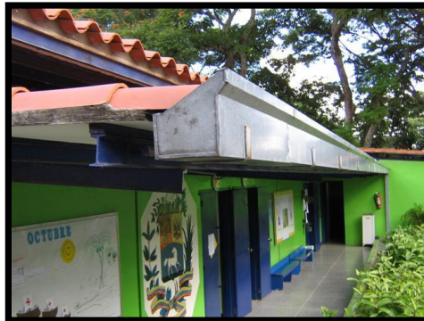
Figura 4.13.12 Edificación 1 pasillo de circulación y techo
