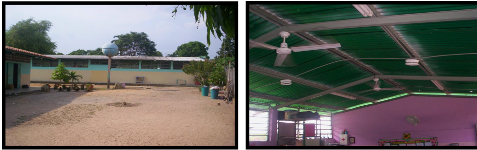
Figura 4.13.24 C.E.I.S. Rómulo Gallegos, Estado Cojedes
