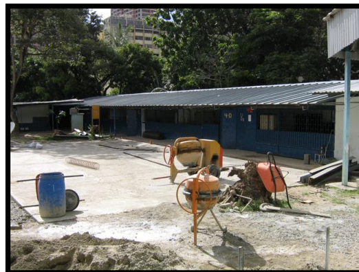
Figura 4.13.3 Edificación 1. Tipo R-4, cubierta láminas metálicas corrugadas
