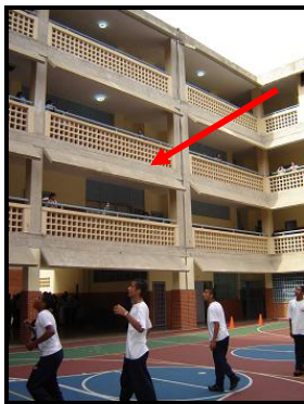
Figura 4.10.9.- Vista general y junta de construcción entre los dos edificios con una separación de 7 cm. E. B. N. Fernando Peñalver
