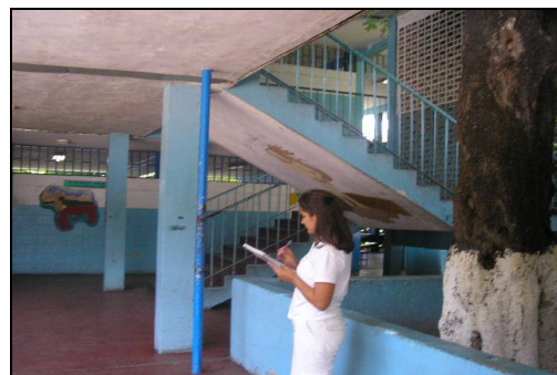
Figura 4.6.59.- Escalera apoyada en uno de los módulos.
