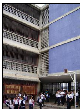
Figura 4.10.4.- Fachada Este de la U. E. N. Padre Sojo. Fotografía tomada desde el patio interno de la escuela. Se observa la presencia de paredes de ventilación, parasoles y planta baja libre del edificio Norte
