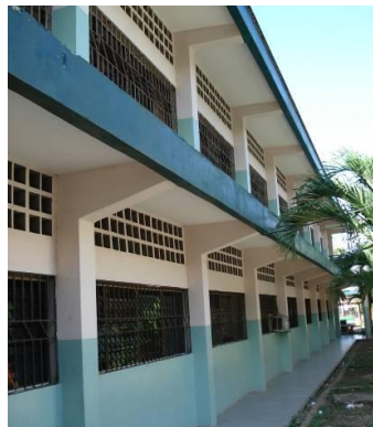
Figura 4.9.11.- Fachada Posterior del Módulo 3.
