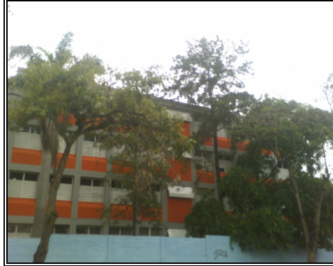
Anexo 4.15.1.- Fachada Norte, edificio A.
