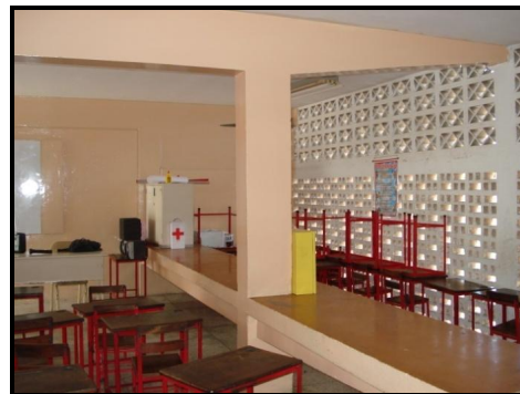
Figura 4.6.7.- Banco de concreto dentro de los salones de clases
