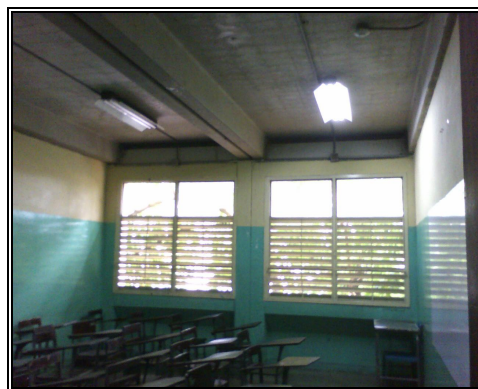
Anexo 4.15.23.- Salón, primer piso, edificio A.
