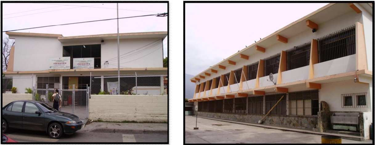
Figura 4.14.1.- Fotografías del Módulo Principal de la U.E. Dr. Lisandro Lecuna, Tipo Antiguo II, Fachada Este (foto izquierda) y Fachada Sur (foto derecha).
