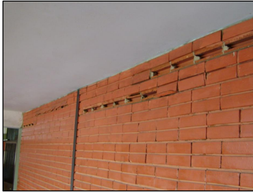
Figura 4.11.7.- Mampostería de bloque tipo tricote / losa del nivel de techo
