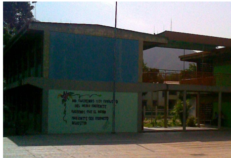
Anexo 4.16.14.- Fachada oeste del Módulo 2.
