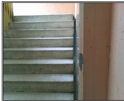
Anexo 4.15.9.- Separación Escalera-Edificio, planta baja, edificio A.
