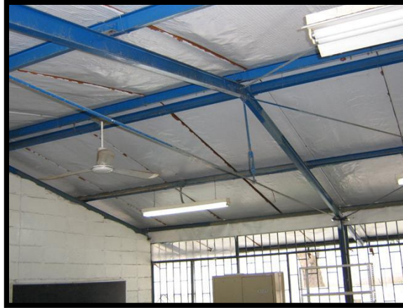
Figura 4.13.4 Edificación 1. Tensores de arriostramiento de pórticos
