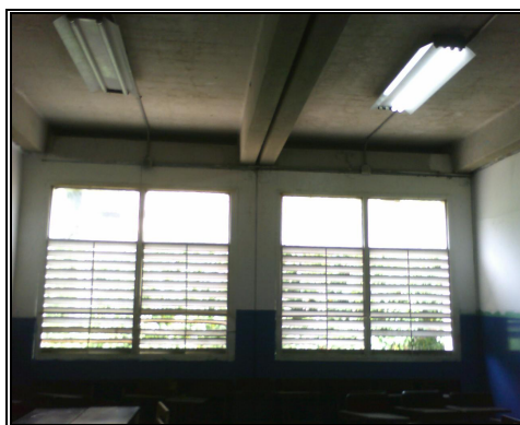
Anexo 4.15.29.- Unión de dos Módulos, segundo piso, edificio A.
