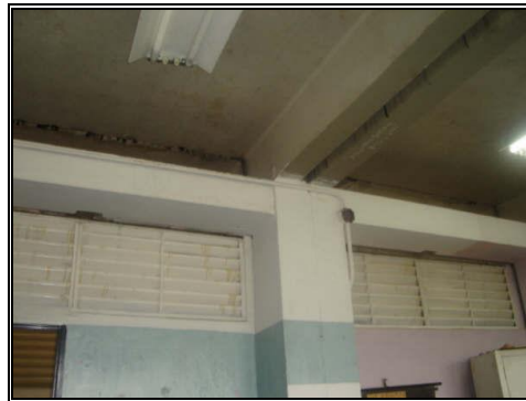
Anexo 4.15.35.- Unión Módulos-Losa de Techo, tercer piso, edificio A.
