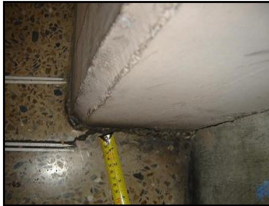
Figura 4.10.50.- Junta del Edificio Norte en la parte superior de la losa del nivel 1
