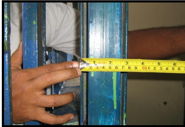
Figura 4.13.7 Edificación 2. Columnas de perfiles tipo IPN80
