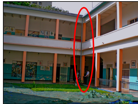
Figura 4.12.13. Vista del patio triangular en el edificio este. Obsérvese la junta estructural
