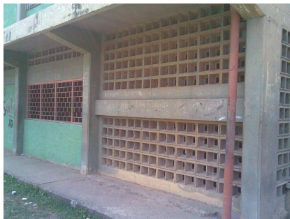
Anexo 4.16.3.- Viga de apoyo del descanso de la escalera, presente en Módulos 2 y 4.
