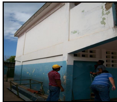
Figura 4.6.17.- Fachada Este y Oeste
