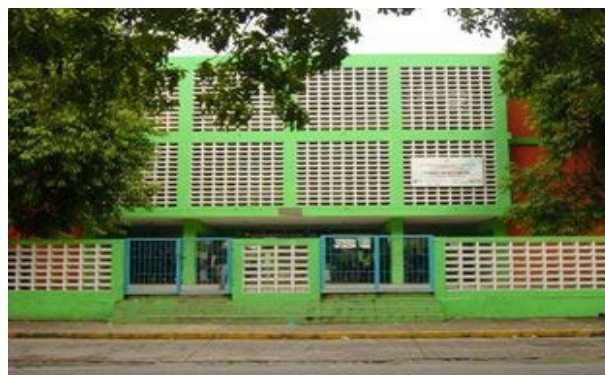
Figura 4.17.2.- Fachada principal (este).
