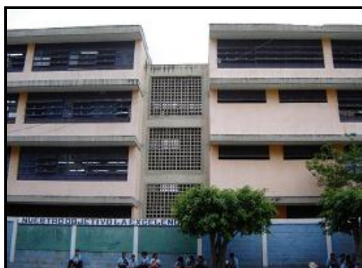
Figura 4.10.5.- Fachada Oeste de la U. E. N. Padre Sojo. Se observan las paredes de ventilación en el módulo de la escalera.
