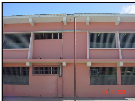
Figura 4.8.8. Junta de construcción y ventanas reducidas en altura.
