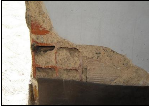
Figura 4.10.27.- Tabiquería constituida por bloques de arcilla. Imagen tomada en la fachada Sur, entrada principal de la U. E. N. Padre Sojo.
