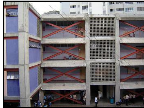
Figura 4.10.8.- Fachada Este de la U. E. N. Julio Bustamante. Se observa el módulo de la escalera y los refuerzos de la edificación.
