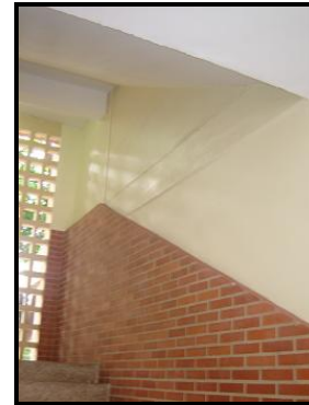
Figura 4.10.11.- Escaleras de acceso a los niveles superiores. En la imagen se puede apreciar la presencia de vigas altas en ambas direcciones. E. B. N. Fernando Peñalver.
