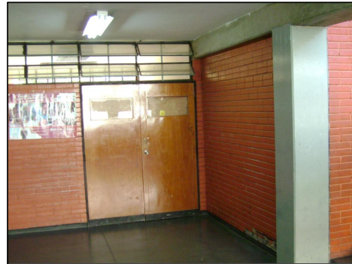
Figura 4.11.8.- Volado externo con parasoles de mampostería / altura incompleta en paredes internas
