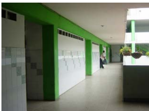
Figura 4.17.8.- Corredor del ala norte del 1er. piso, visto desde el este hacia el oeste.
