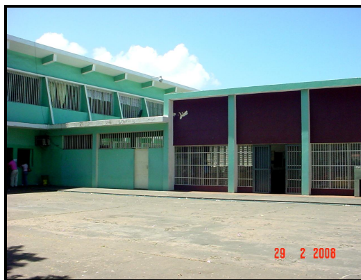
Figura 4.8.6. Módulo Anexo rígidamente conectado al Modulo Principal.
