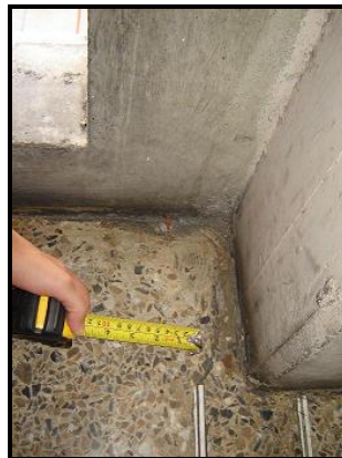
Figura 4.10.51.- Junta del Edificio Sur en la parte superior de la losa del nivel 1
