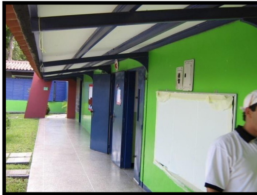
Figura 4.13.17 Edificación 2. Fachada sur
