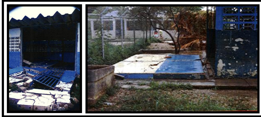
Figura 4.13.53 Volcamiento de pared durante el Sismo de Cariaco de 1997.
