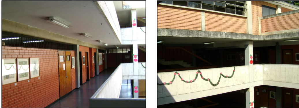
Figura 4.11.5.- Pasillo interno / tercer nivel vista interior.
