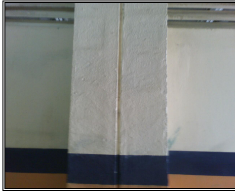
Anexo 4.15.25.- Columna Interior, segundo piso, edificio A.
