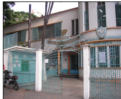
Figura 4.12.10. Fachada principal de la Experimental Venezuela
