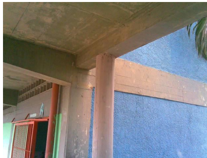
Anexo 4.16.13.- Junta entre el pasillo y el Módulo 2.
