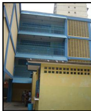
Figura 4.10.13.- A la izquierda se observa uno de los módulos independientes de la escalera, a la derecha se observa el otro; ambos con paredes de ventilación. También se observan las estructuras anexas en la imagen derecha. E. B. N. Elías Rodríguez.
