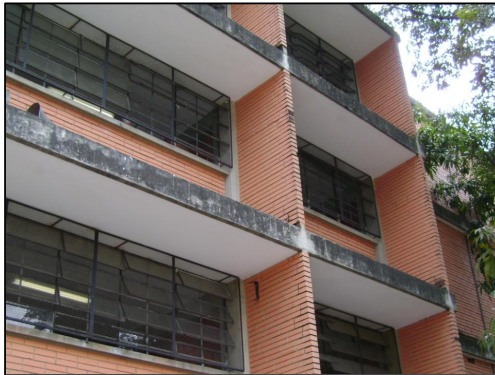
Figura 4.11.8.- Volado externo con parasoles de mampostería / altura incompleta en paredes internas
