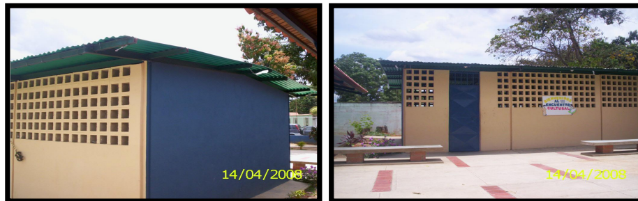
Figura 4.13.19 C.E.I.B. Caja de Agua II, Estado Aragua
