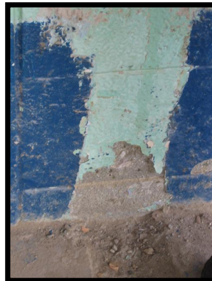
Figura 4.13.2 Mampostería con bloques de concreto
