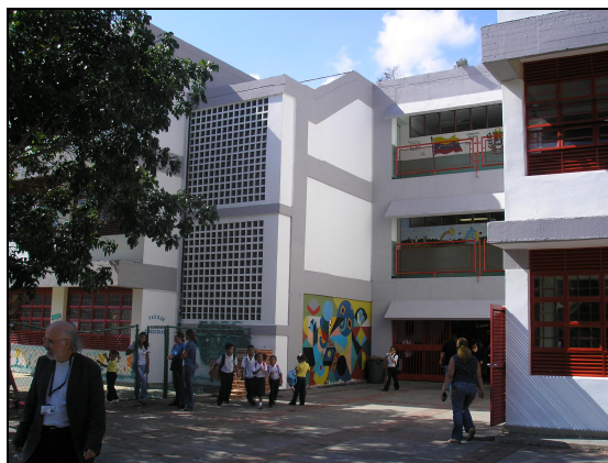
Figura 4.12.8. Vista de la edificación escolar
