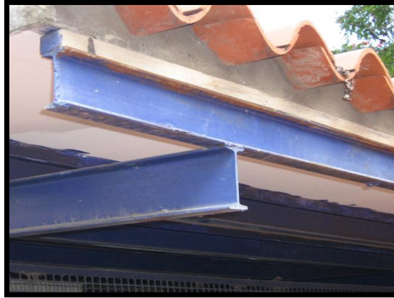
Figura 4.13.14 Edificación 1 Detalle de la cubierta de techo. Apreciarse el espesor del mortero debajo de las tejas
