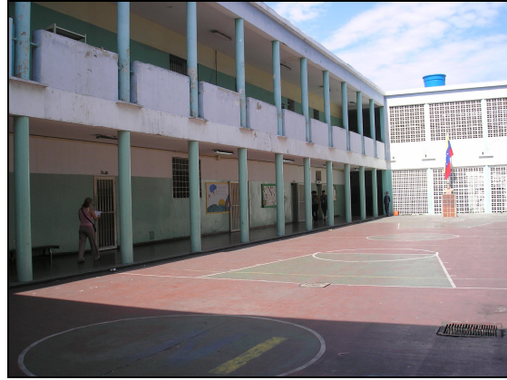
Figura 4.12.4. Vista del patio oeste
