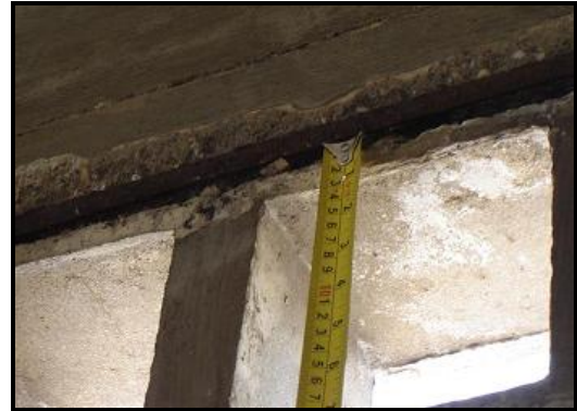
Figura 4.10.28.- Pared de ventilación del 3° piso, donde se pone en evidencia el refuerzo.
