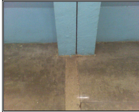
Anexo 4.15.16.- Unión Losa-Columna, primer piso, edificio A.
