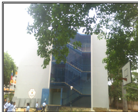
Anexo 4.15.3.- Fachada Este, edificio A.
