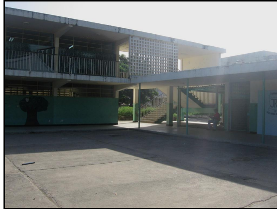
Figura 4.6.35.- Se observa que las escaleras están conectadas al final de cada edificio.
