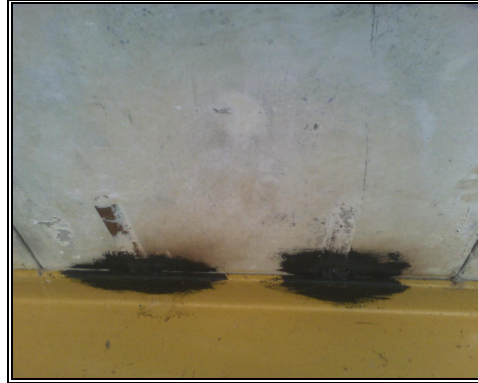
Anexo 4.15.13.- Soldadura Muro-Perfil, planta baja, edificio A.
