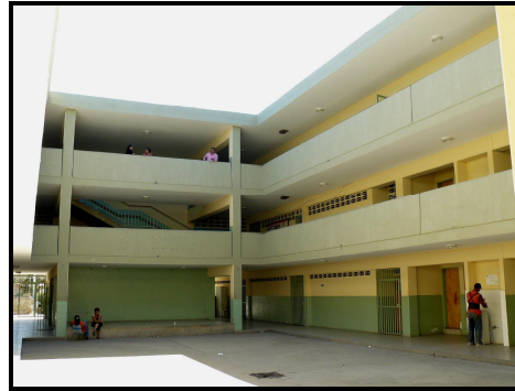
Figura 4.7.4.- Vista desde el patio interno de la Corazón de Jesús
