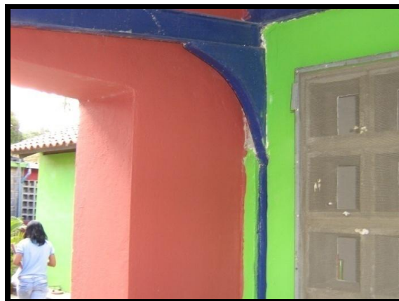
Figura 4.13.16 Edificación 2. Cartelas para soporte de alero
