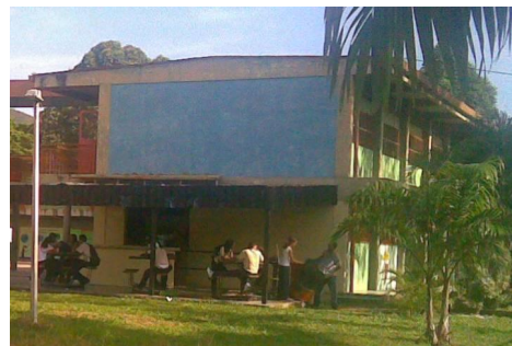
Anexo 4.16.8.- Fachada Norte del Módulo 1.
