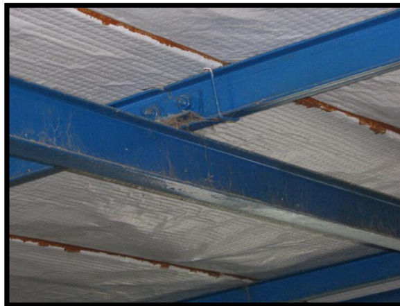
Figura 4.13.5 Edificación 1. Uniones apernadas en techo
