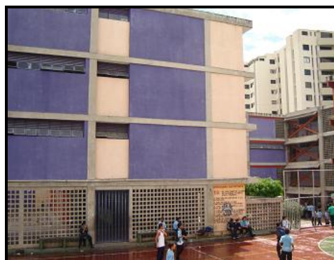
Figura 4.10.3.- Fachada Norte de la U. E. N. Padre Sojo. Se aprecia la dimensión 6,90 m y el volado de 3,40 m. Al fondo se encuentra la U. E. N. Julio Bustamante.
