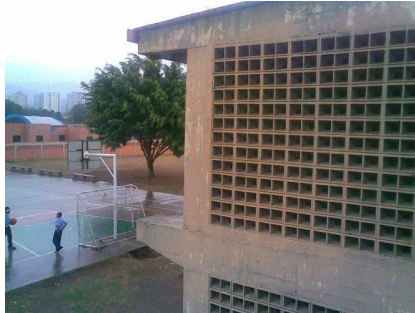
Anexo 4.16.20.- Fachada oeste del Módulo 4.
