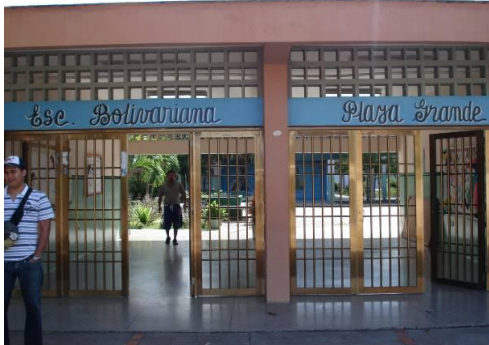
Figura 4.9.1.- Entrada Principal de la Escuela
