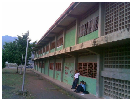
Anexo 4.16.18.- Fachada norte del Módulo 4.
