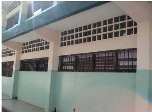
Figura 4.9.3.- Fachada Posterior del Módulo 1
