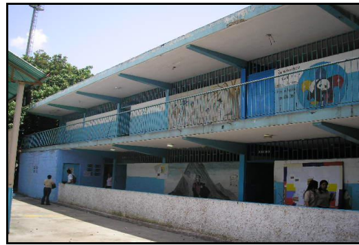
Figura 4.6.40.- Fachada sur del primer módulo.
