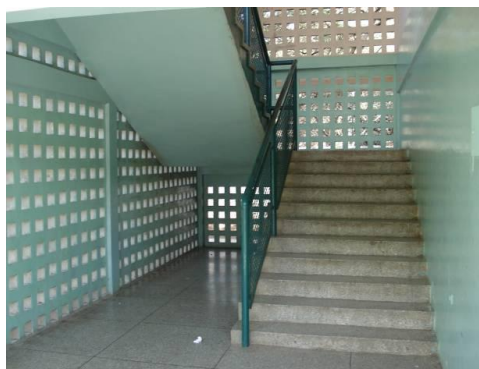
Figura 4.9.5.- Vista de escalera del Módulo 1
