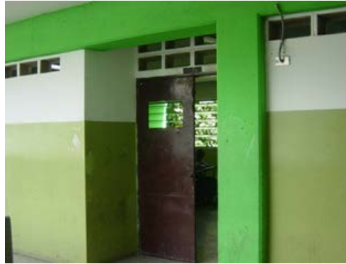
Figura 4.17.10.- Detalle de puerta y ventanas, ala norte.
