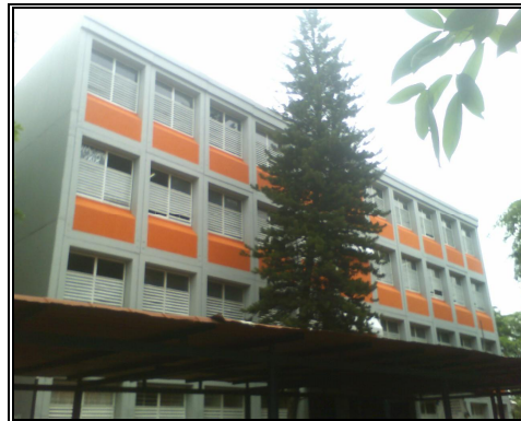
Anexo 4.15.2.- Fachada Sur, edificio A.
