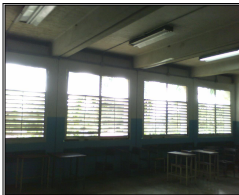
Anexo 4.15.28.- Unión de Módulos, Columnas Perimetrales, segundo piso, edificio A.
