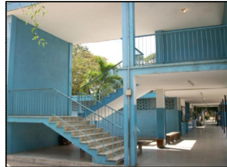
Figura 4.6.6.- Modulo de escaleras
