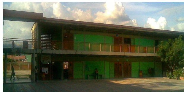
Anexo 4.16.19.- Fachada sur del Módulo 4.
