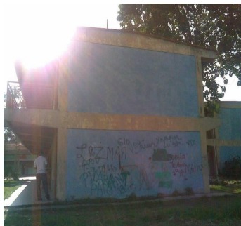
Anexo 4.16.15.- Fachada este del Módulo 3.
