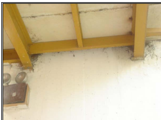
Anexo 4.15.22.- Unión Descanso-Muro, primer piso, edificio A.
